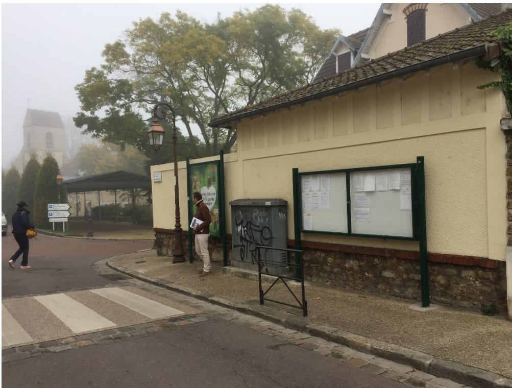
Photo n° 6 Avenue Clemenceau, au débouché de la Place de l'Église
